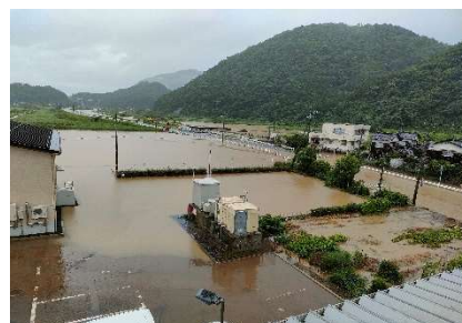
写真28: 塩見川水害状況
