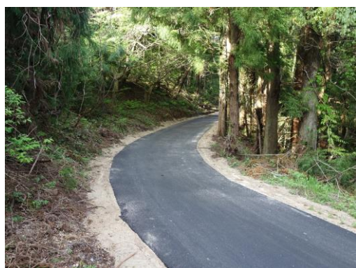
右岸下流 アスファルト舗装改修区間
