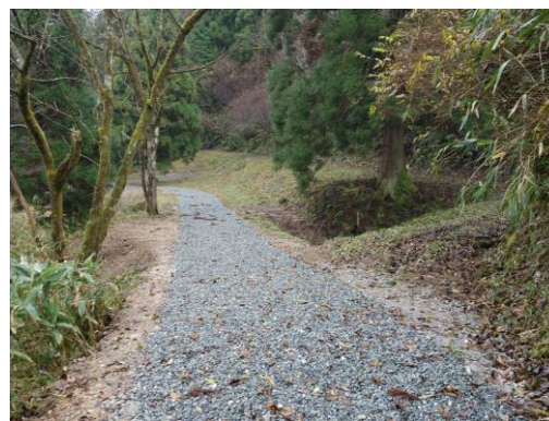
左岸上流 砂利敷き舗装区間
