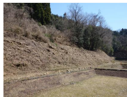
濾過池東側法面(伐採)
