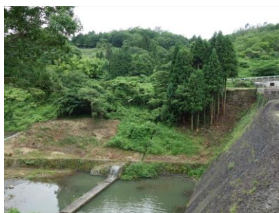
砂防堰堤右岸側(伐採)
