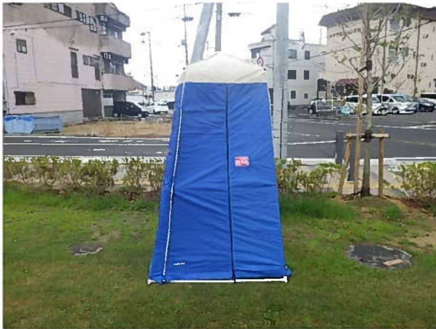
マンホールトイレ
