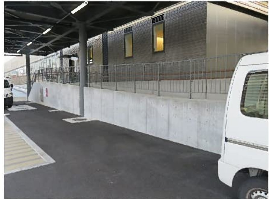
嵩上げ(職員通用口付近)
