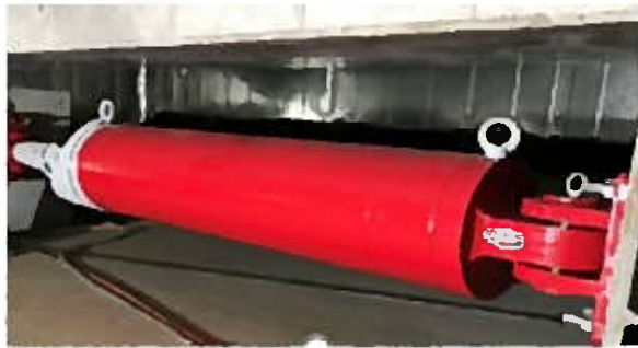
(地震エネルギーを吸収する免震オイルダンパー)
