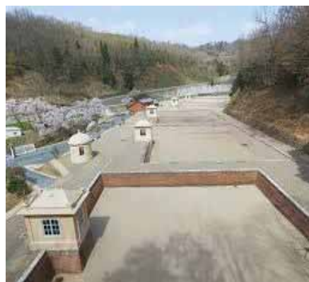
旧美歎水源池水道施設
