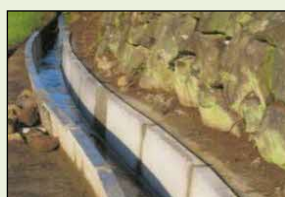
素堀り水路からの更新
