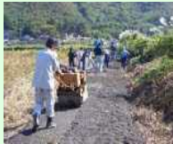
未舗装農道の舗装
