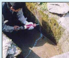
ひび割れの補修
