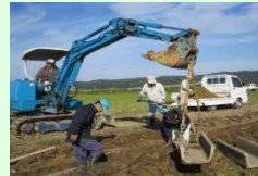
コンクリート水路の更新
