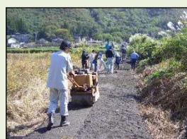
未舗装農道の舗装
