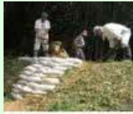
漏水箇所の補修
