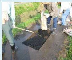
農道の部分補修
