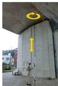
ロボットカメラを使用した点検
