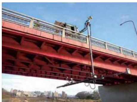
橋梁点検支援ロボットによる点
