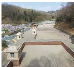
旧美歎水源地下水道施設
