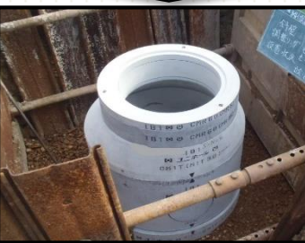
写真2 マンホール本体
