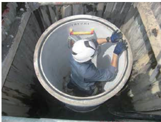
マンホール設置作業
