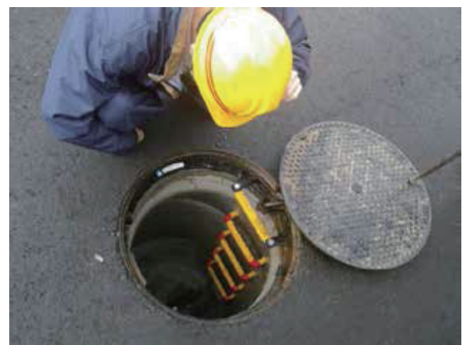
マンホール検査の様子
