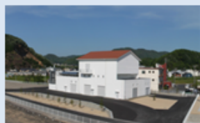
秋里雨水ポンプ場
