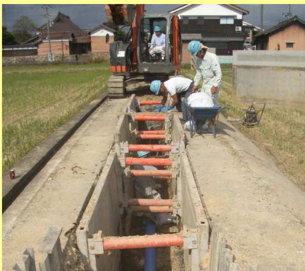
下水道管の敷設工事の様子
