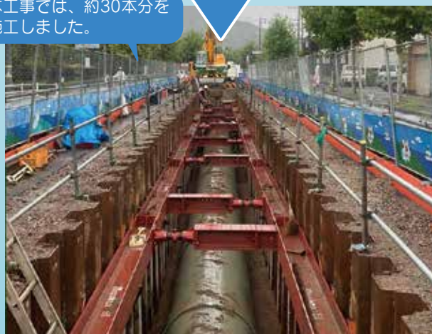
雨水管施工中
