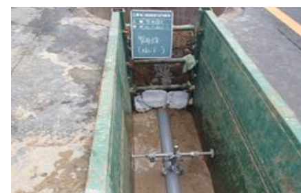
未普及対策下水道事業による管布設状況
