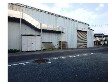
玄好町地内マンホールトイレ整備
