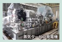
ごみを焼却する際に発生する 高温の熱を利用してボイラで水 蒸気を発生させ、蒸気タービン を回し発電を行います。発電し た電気は施設内で利用し、余剰 電気は売電します。
