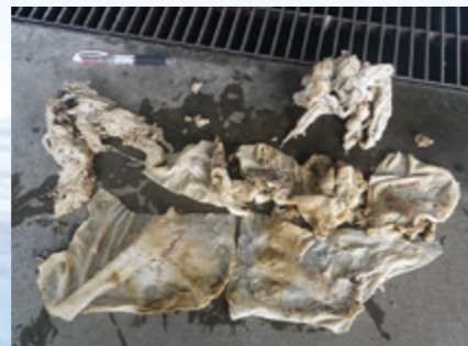
詰まったポンプから取り出されたタオルなどの布類
