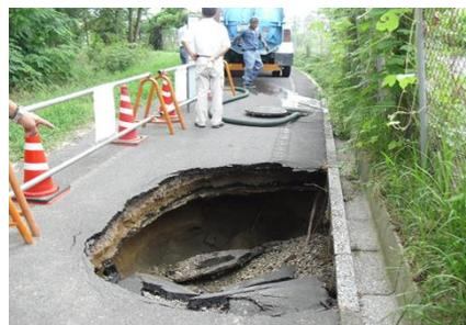
鉄筋コンクリート管の腐食による陥没事故
