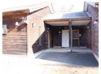
⑤トイレ・シャワー室
