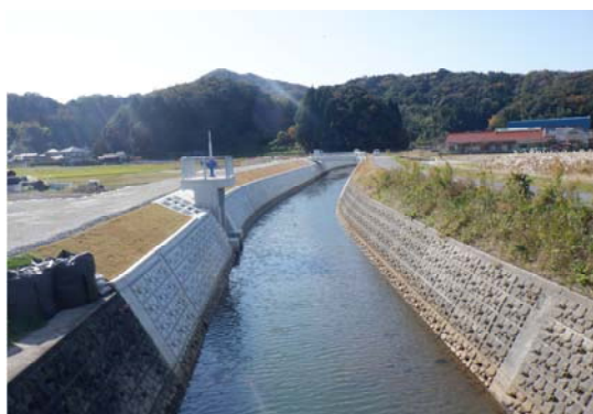
露谷川河川改修工事
