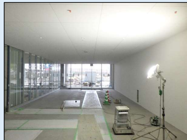
②エントランスホール
