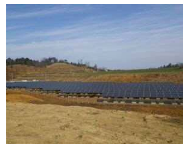
【鳥取市青谷町いかり原太陽光発電施設】
