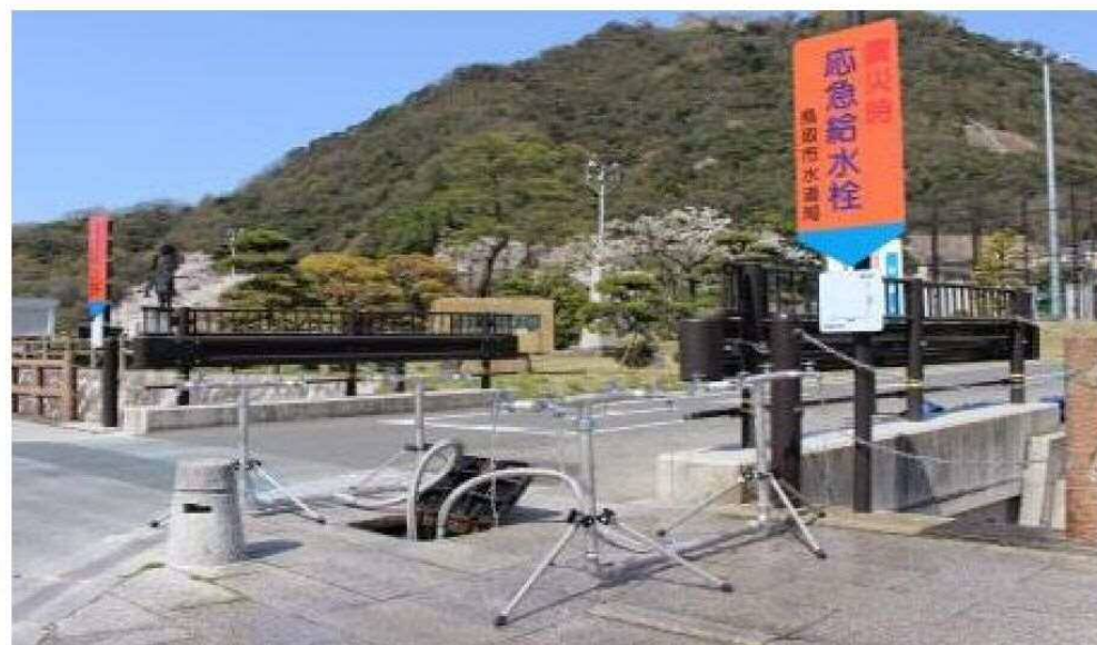
応急給水拠点 (鳥取西高等学校)
