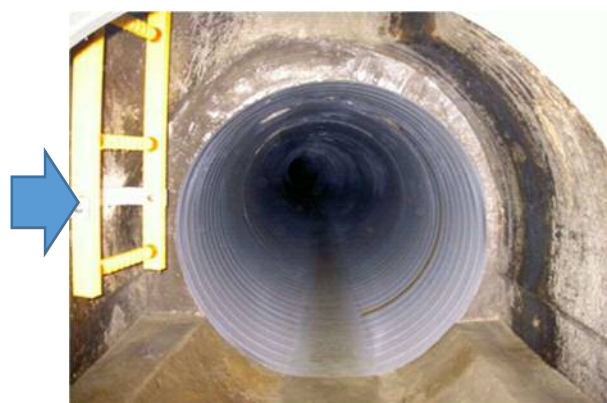
図 30 管更生実施後
