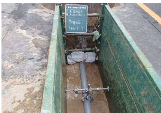
図 24 汚水管の敷設
