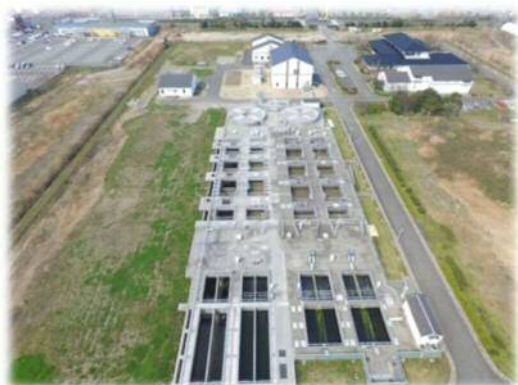
図4 千代水クリーンセンター
