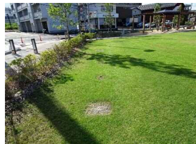
マンホールトイレ
