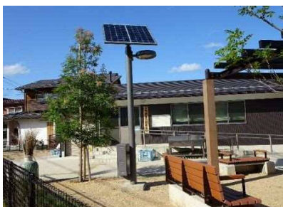
ソーラーパネル付照明灯
