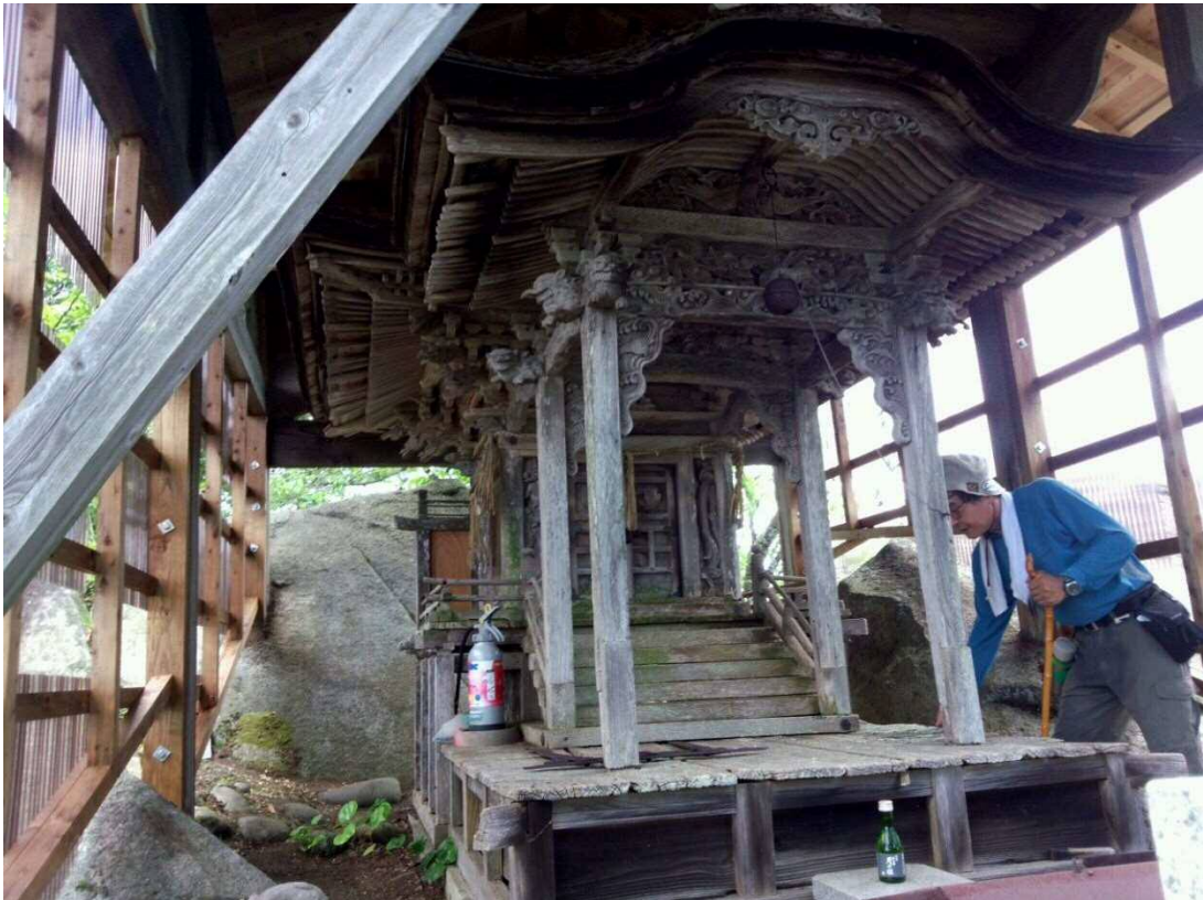
焼失前の社殿（平成 27 年撮影・保護のための覆屋内）
