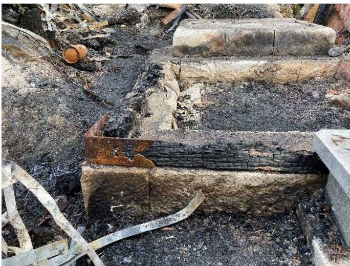
本殿残材（昭和の改修）
