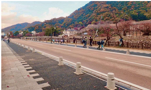
街なみ環境整備事業により美化、無電柱化、歩道拡幅を行ったお堀端通り。歩道拡幅により、生徒の通学時における安全性が確保された。
