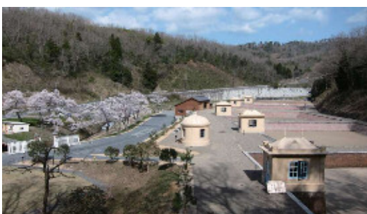
● 旧美歎水源地水道施設
