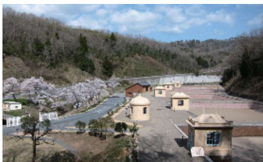
● 事例：保存修理工事を行った重要文化財旧美歎水源地水道施設
