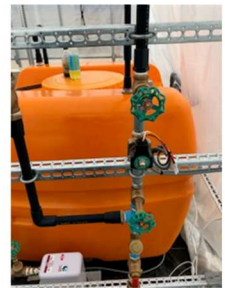
制御部分（温泉水電磁弁・循環ファン・カーテン・窓）
