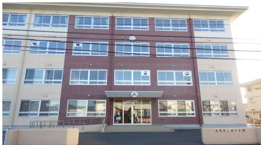
鳥取市立南中学校増改築事業（令和3年10月21日竣工）
