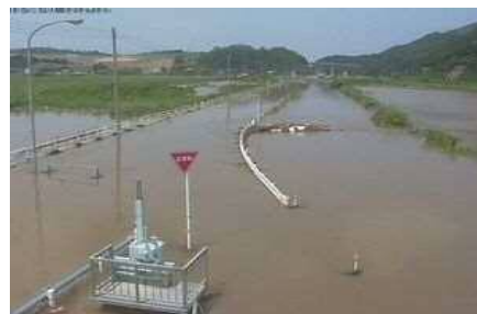
写真33: 以前の塩見川水害状況
