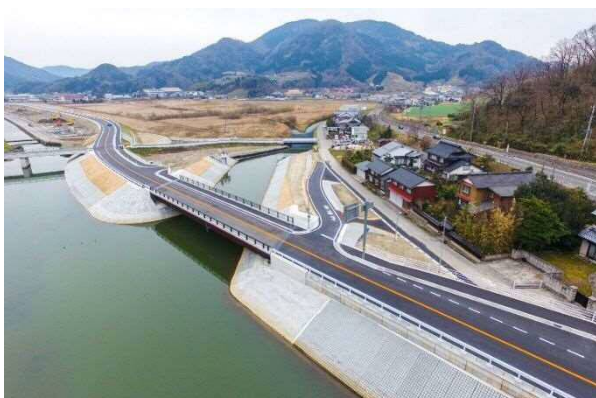
写真3: 箭溪川（江川）との合流部の改修状況
