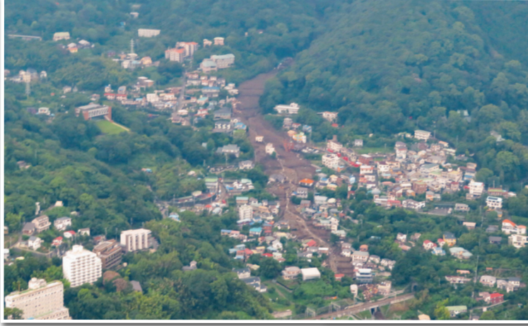
R3.7 静岡県熱海市 死者28名、住宅被害98棟
