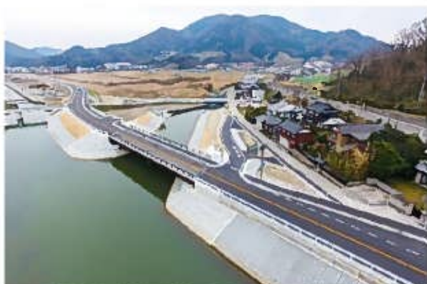
写真3: 箭溪川（江川）との合流部の改修状況
