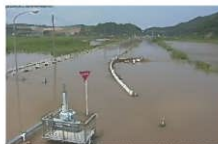
写真33: 以前の塩見川水害状況
