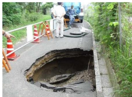
図 22 鉄筋コンクリート管の腐食による道路陥没
