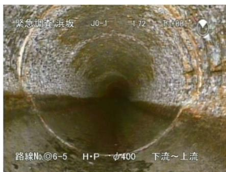
図 21 鉄筋コンクリート管の腐食状況（S50年敷設）
