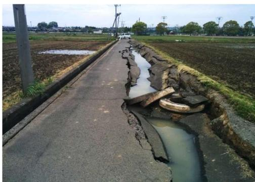
図 18 汚水幹線の路面陥没 (出所：国土技術政策総合研究所資料)
