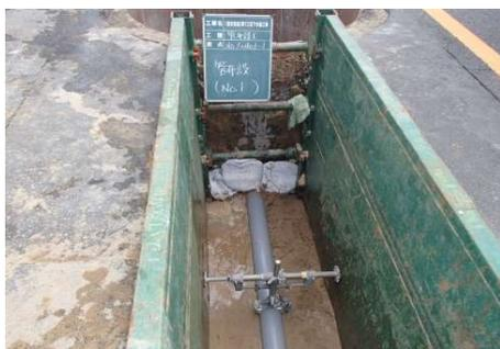
図 23 汚水管の敷設
