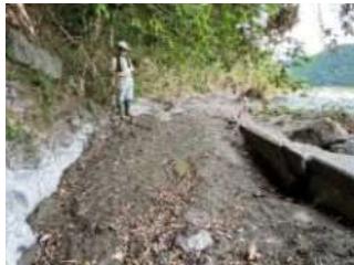
土砂埋没による通水機能の喪失 (R5.9.5撮影)
