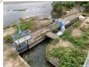
※ 排土工事中は代替ポンプを稼働 R5.9.6撮影)
