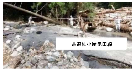
県道被災状況(北村地区)
