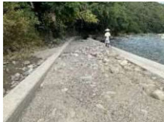
土砂埋没による通水機能の喪失 (R5.9.5撮影)
