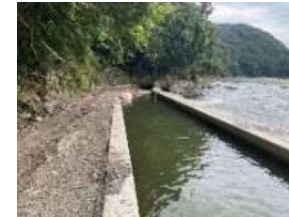
排土による通水確保 (R5.9.24完了)
