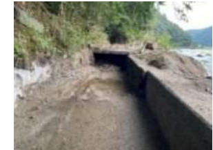
排土による通水確保 (R5.9.24完了)
