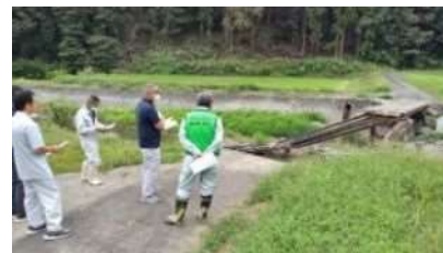
※ 現地確認 (R5.9.26 八頭町橋梁被災箇所)
