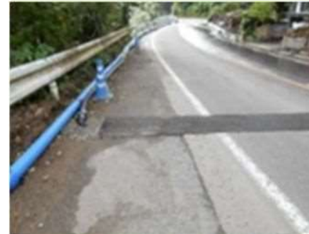
＜鳥取市佐治町高山＞ 橋崩落⇒迂回管路を 仮設
