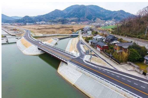
写真3: 箭溪川（江川）との合流部の改修状況
