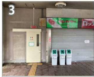
3 ・多目的トイレが待合室の外にあり使いづらい
