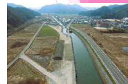
塩見川河川改修事業
