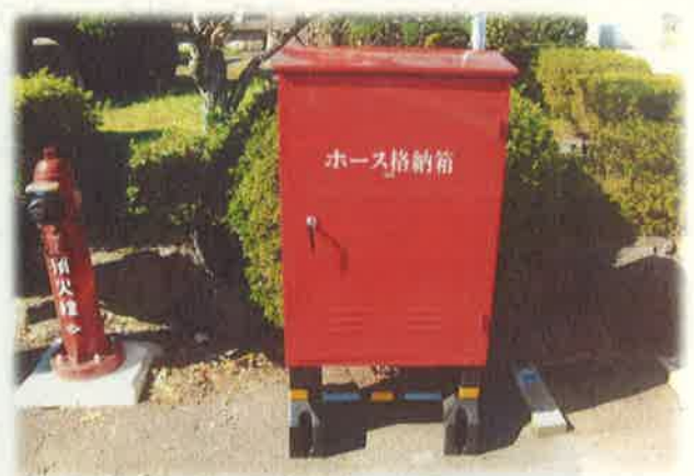
ホース格納庫の改修
