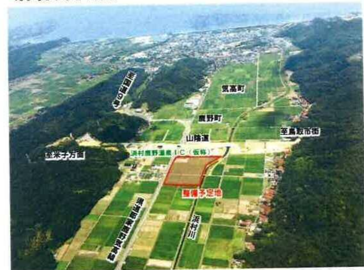
整備位置周辺状況
