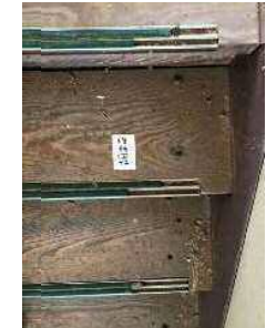
H. 階段踏み板(松)…2箇所
