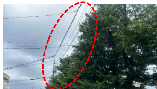
枝の電線干渉状況
