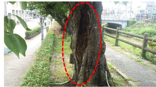
開口し空洞が大きくなったサクラ
