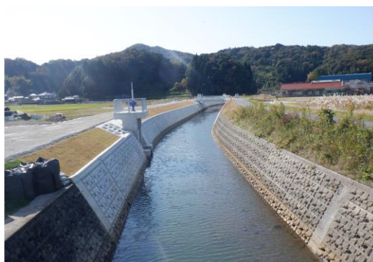
露谷川河川改修工事
