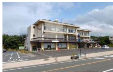
廃屋の撤去 (旧砂丘フレンド)
