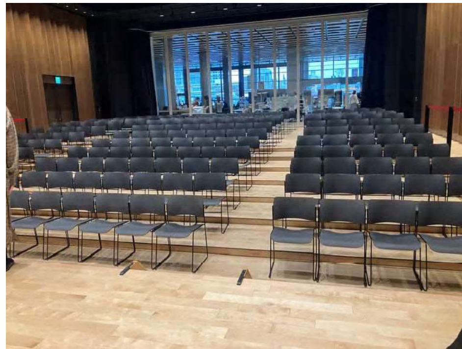
床は可動式で、フラットな平土間とすることも 段差式にすることも可能。 後ろ側の壁はガラス張りになっており、開け放つことも可能。 （開け放つと、エントランスと一体的な空間となる）
