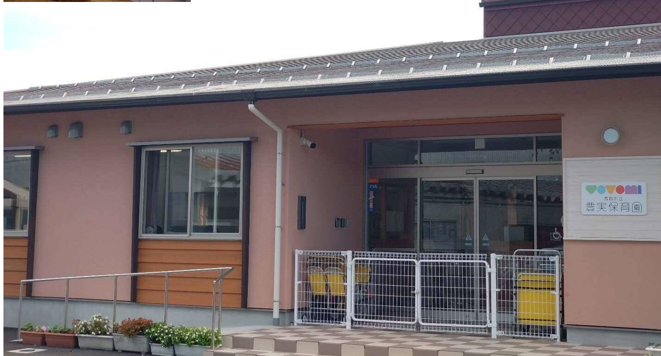
鳥取市立豊実保育園（令和6年3月新園舎完成）
