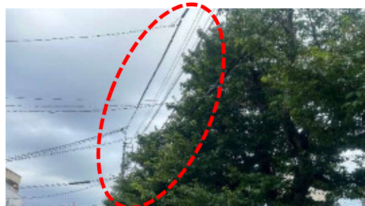
枝の電線干渉状況
