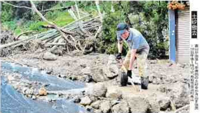
道路が崩れ、鳥ん川に水を通る土管などが壊れた穴の隙間から水を流す作業。16日午前10時30分、三原町内川の加藤川
