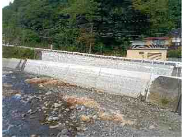
古市上八幡坂付近 R6. 8. 16 復旧工事完成
