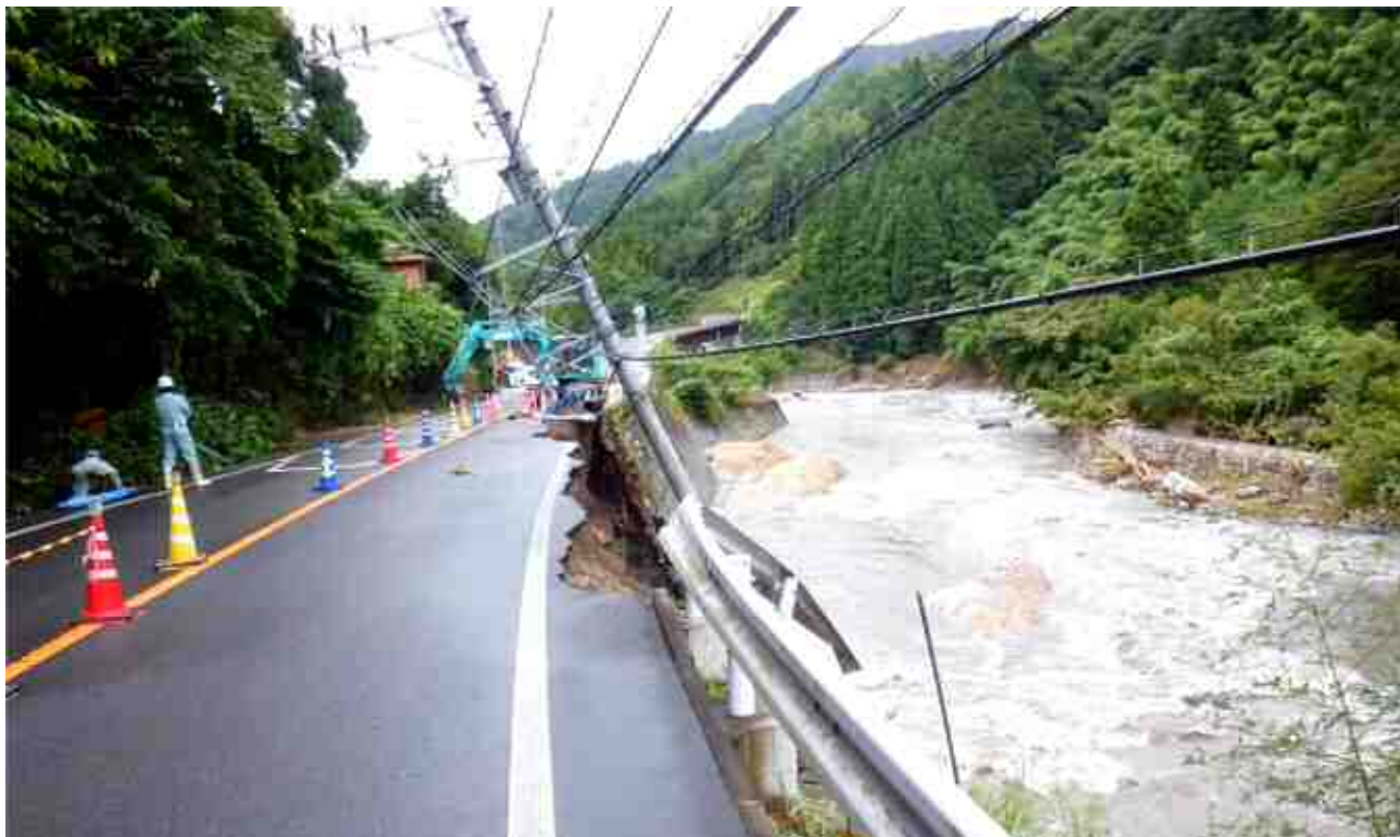
復旧工事開始
