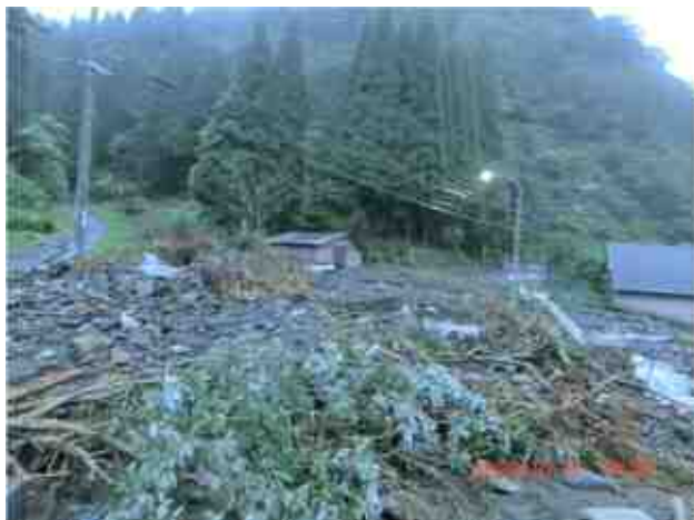
余戸和田河原付近国道へ土砂流入 R5. 8. 17 写真左側の谷から土砂流入
