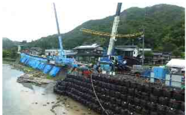
別府付近 R6. 8. 23 復旧工事中
