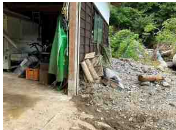
尾際 住宅敷地土砂流入 R5. 8. 20
