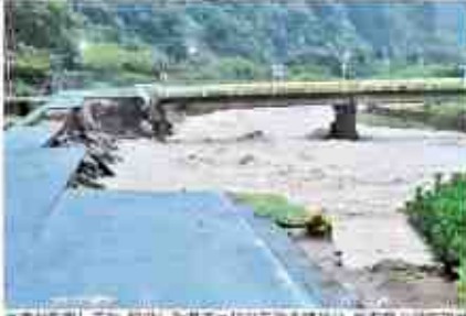
濁水が激流して、崩壊した橋脚。15日午後の撮影。鳥取県八幡町橋頭
