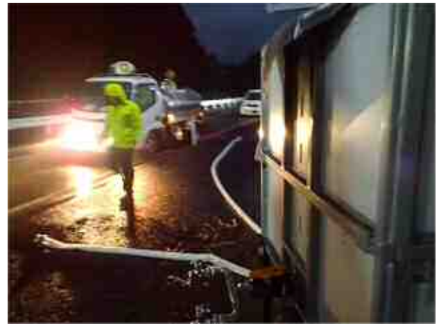
応急給水作業 佐治町総合支所前 R5. 8. 19 夜
