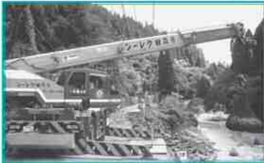
復旧工事が進められている国道482号線の森坪付近
