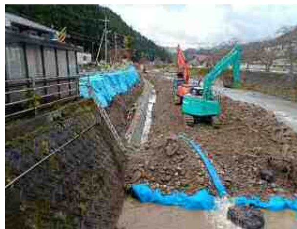
佐治コミュニティセンター付近 R6. 12. 9 復旧工事中
