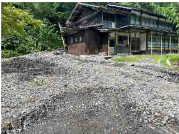
栃原 住宅敷地に土砂流入 R5. 8. 20 住宅裏の谷から土砂が流出した
