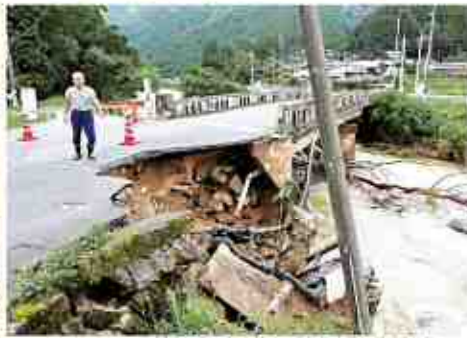
道路が崩れ、鳥ん川に水を通る土管などが壊れた穴の隙間から水を流す作業。16日午前10時30分、三原町内川の加藤川
