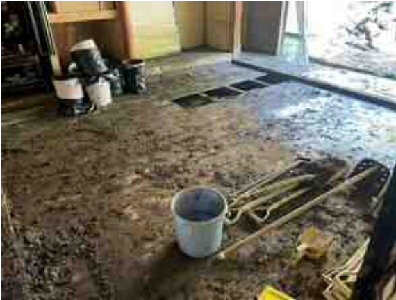
加瀬木 住宅床上浸水 R5. 8. 28
