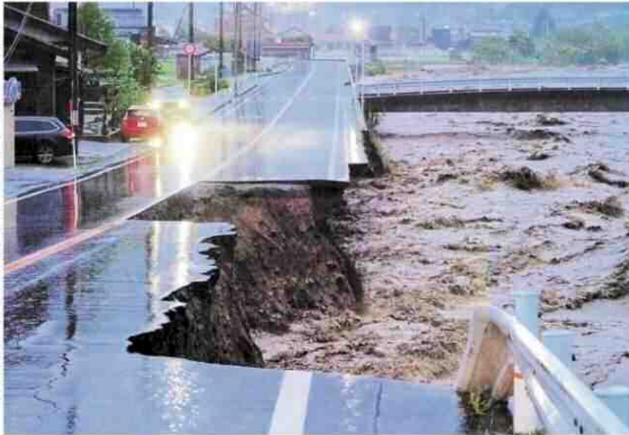
濁流に削られて崩落した国道482号。15日午後6時46分、鳥取市用瀬町別府
