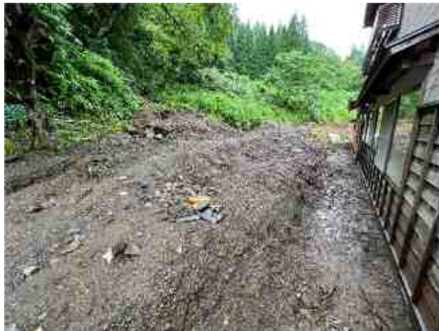
中集会所裏 土砂撤去後 R5. 9. 1
