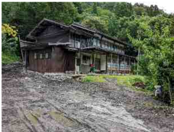
土砂撤去 R5. 9. 1
