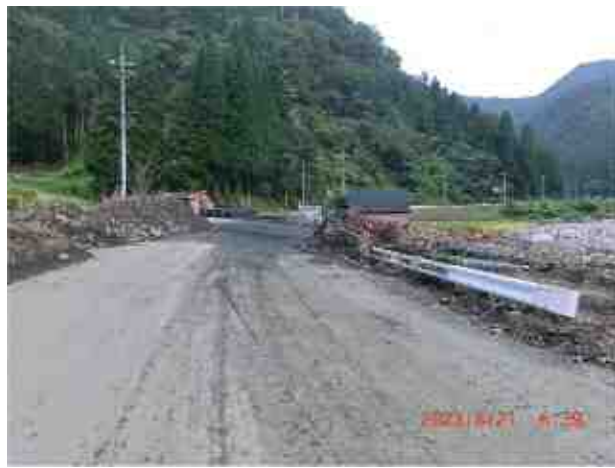
余戸和田河原付近 R5. 8. 21 重機により路面上の土砂撤去（応急措置）
